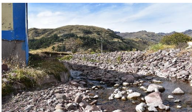
FOTO 01: Sección hidráulica del cauce del RIO CARACCOTO colmatado con material canto rodado el cual viene estrangulando y interrumpiendo el flujo
