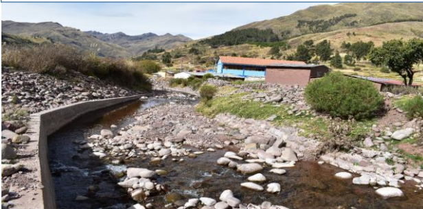
FOTO 03: Se aprecia dique de concreto ciclopeo y emboquillado de piedra, con cauce colmatado
